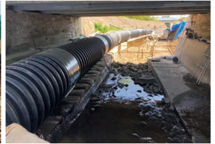
河川改修排水工事
