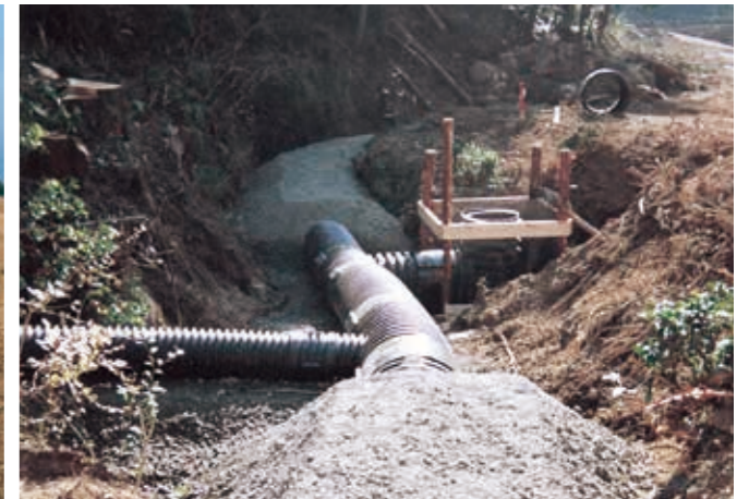
土捨場防災暗渠工事
