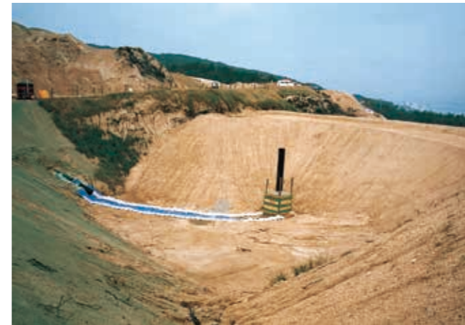
土地造成堅形集排水管工事
