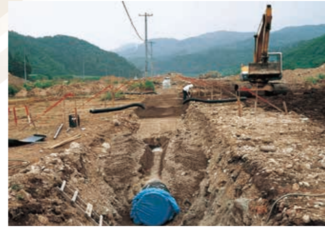
圃場整備小排水路管路化工事
